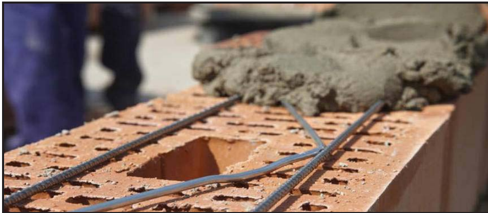
شکل ۱-۳- میلگرد بستر خرپایی قبل از پخش کردن ملات بستر بر روی آن
